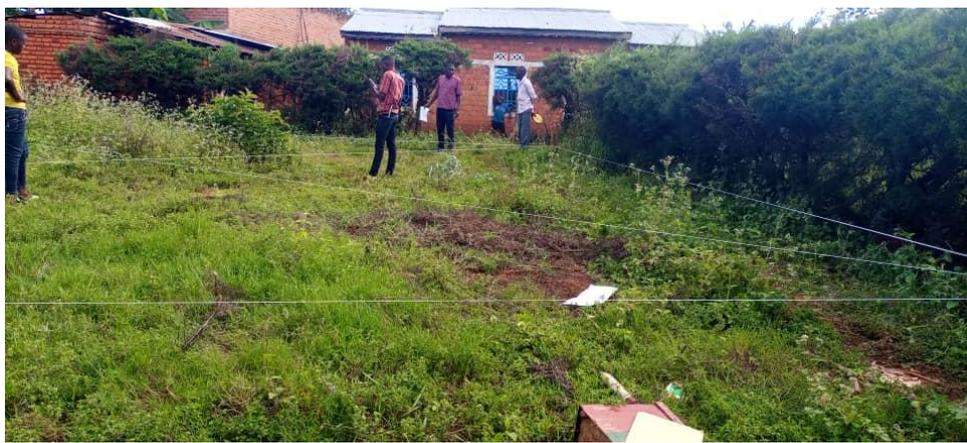
*Photo 2: Implantation pour la construction de la salle à la guérite de réception de Karera (Auteur : NDUWAYO Léonidas, 2023)*
