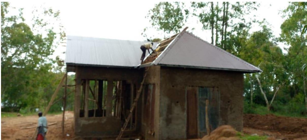
Photo 3 : Guérite de réception des touristes aux failles de Nyakazu, en cours de construction (Auteur : Alexis NIKIZA)
